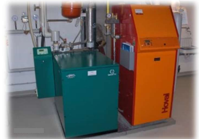
Blockheizkraftwerk
